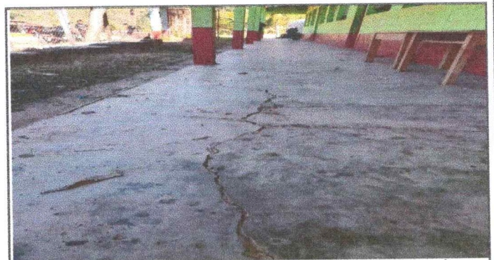
Foto 6: Se observa el deterioro del piso del de corredor y las tres aulas y dirección de la escuela.
