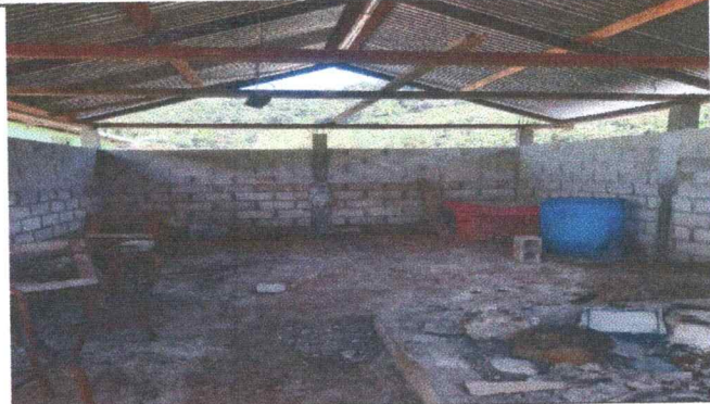
Foto 1. Colocación de piso concreto de la cocina.
